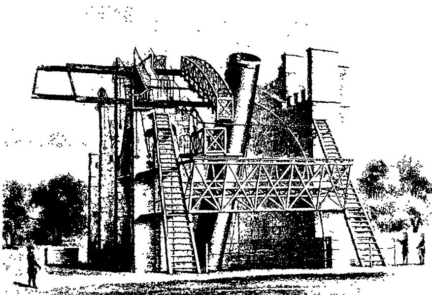
Гигантский телескоп-рефлектор Уильяма Парсонса, сооруженный в 1845 г. Металлическое главное зеркало диаметром 182 см имело фокусное расстояние 17 м.
